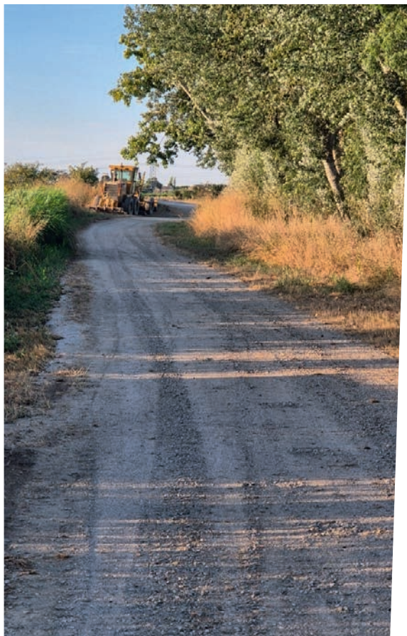
Nivellement de la chaussée de la rue sans incorporation de gravats en direction du canal des Fougères (marais indivis).
